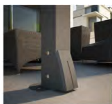
Afvoer van water Drainage de l'eau de pluie
